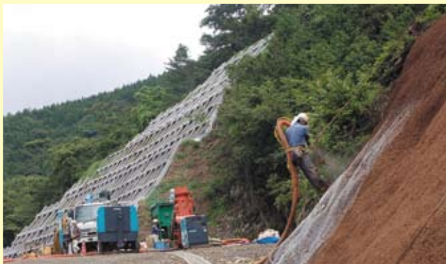
補助材料添加・吹付工
