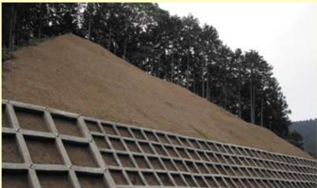
吹付施工直後
