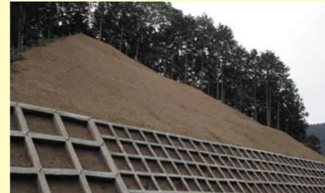
吹付施工直後
