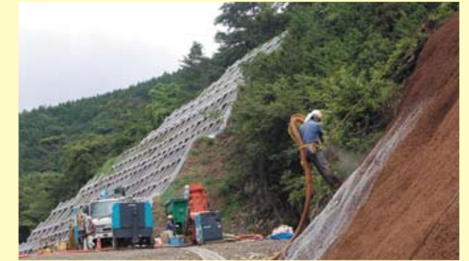
補助材料添加・吹付工
