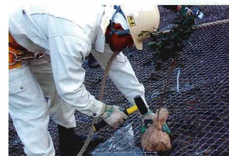
苗木・斜林ベース設置工
