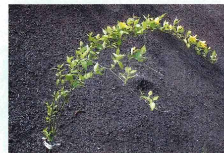
施工直後 ヤマブキ
