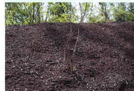
施工中 ウツギ
