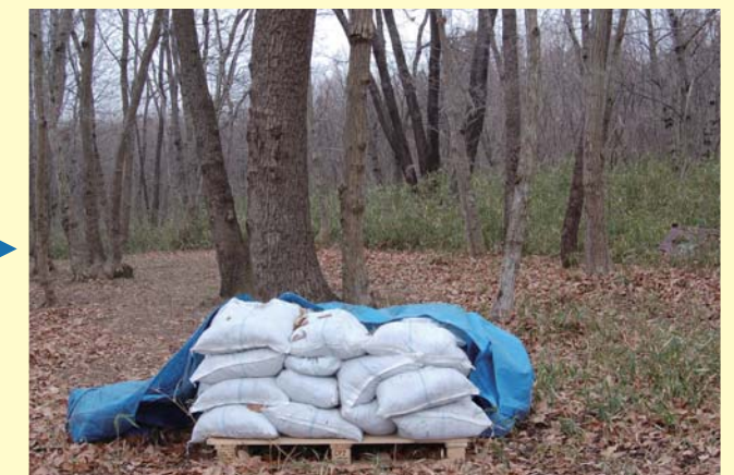
集積・保管工
